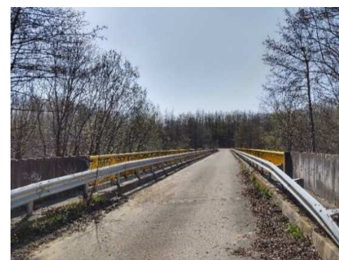
Photo 5 : OA6 vue depuis l'est de la RN19 (googlemaps)
