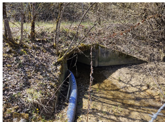
Photo 8 : Affluent de la Douce Ouest - Vue aval
