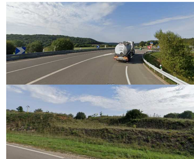
Photo 6 : Diffuseur de Banvillars existant (googlemaps)
