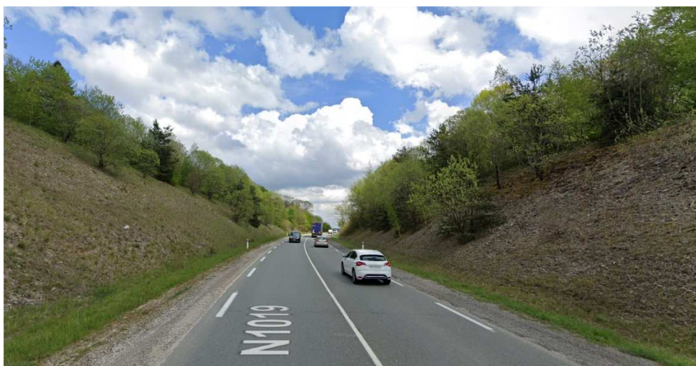
Photo 2 : Passage en déblai au niveau du franchissement du bois de Fays (source : googlemaps)
